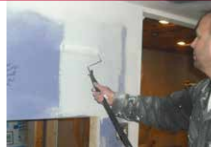
Applying primer to new drywall.
