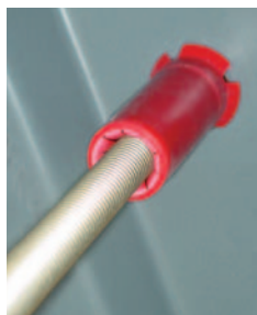
Pour Concrete. Then Install Rod
